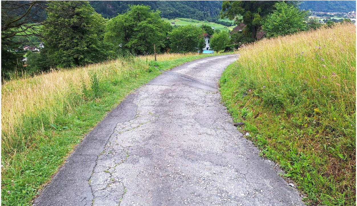
Kurve unterhalb des Wasserreservoirs Stockli, Blick talwärts
